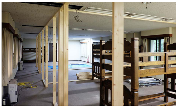
男子寮一階 部屋を仕切る柱が立てられました
