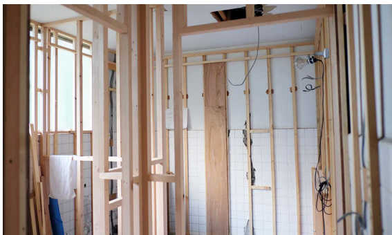
本館トイレ 壁を作ってスペースを区切ります
