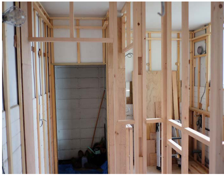
本館トイレ 壁を立ててスペースを区切る
