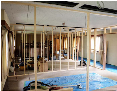
男子寮一階 柱を立てて壁を作る
