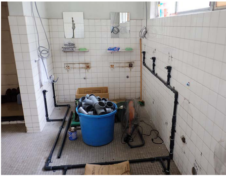
本館トイレ 排水設備が設置された
