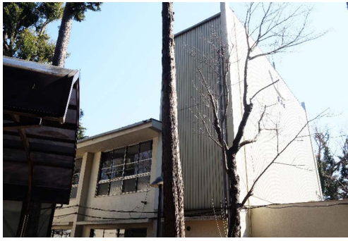
耐震対策として本館の塔部分を取って平屋根に
