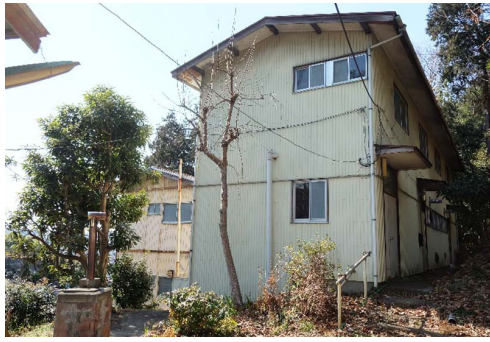
旧家族寮棟・旧オルガン棟は解体し駐車場に
