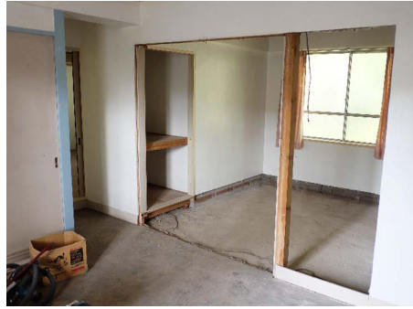
家族寮、床、天井、壁の改装工事
