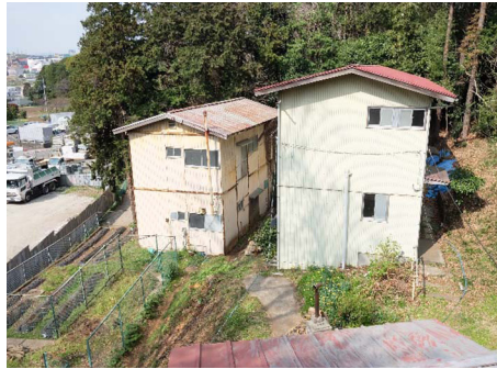
解体予定の旧オルガン棟、家族寮棟
