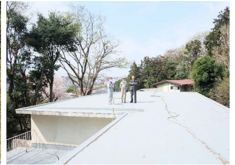
旧女子寮棟屋上防水工事、雨漏りがとまりました
