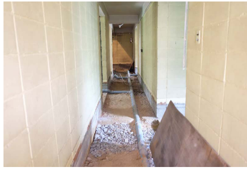
1階廊下 配水管を設置
