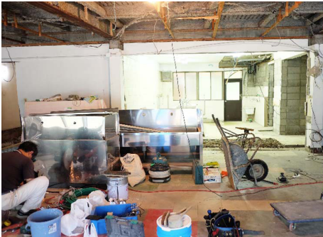
食堂と厨房も改修
