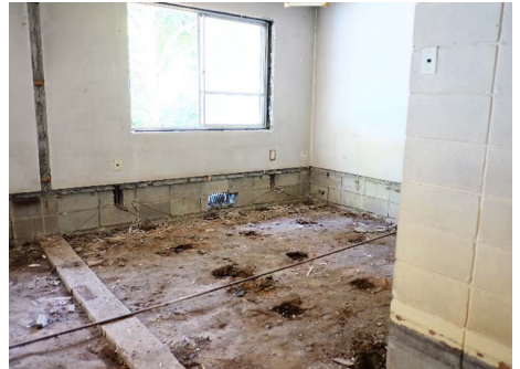
1階 土だった床下にコンクリート打設
