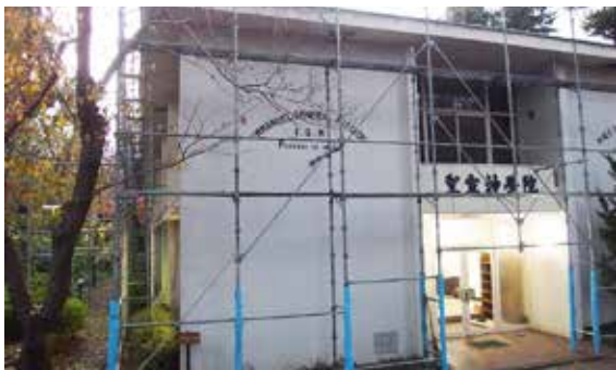
本館屋根工事が始まって足場が組まれました
