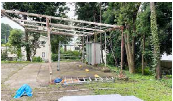
長年の風雨で傷んだガレージの屋根をふき替えました
